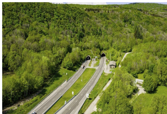
Đường hầm đôi dài 1,4km được mở vào năm 1982 (ảnh: ATMB)
