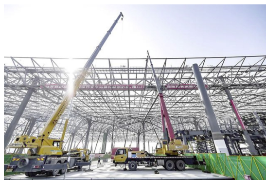
Công tác xây dựng đường sắt của Trung Quốc đang được đẩy mạnh.
