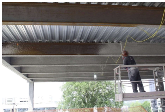
Vữa chống cháy MONOKOTE của công ty GCP được thiết kế để giảm tốc độ tăng nhiệt độ trong kết cấu thép hoặc bê tông trong trường hợp hỏa hoạn.
