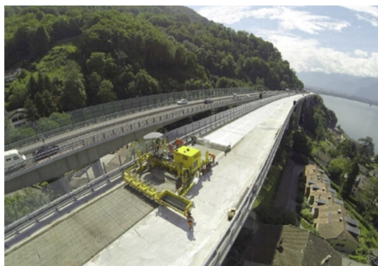
Bê tông cốt sợi siêu cường trong xây dựng cầu đường bộ tại Vùng Viễn đông, Liên bang Nga.
