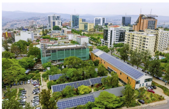
Tấm pin mặt trời đang chuyển đổi sản xuất năng lượng ở Kigali, Rwanda. Ảnh: Mucyo Serge/UNDP Rwanda
