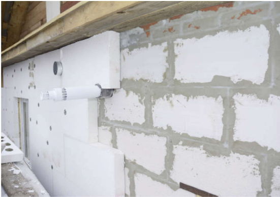
Xốp polyurethane cứng gốc thực vật có khả năng bảo vệ chống lại côn trùng và nấm mốc. Ngoài ra, nó còn chịu được nhiệt, chống côn trùng và nấm mốc, và có thể cách âm rất tốt.
