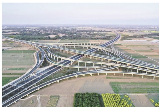
Nút giao thông đa tầng thuộc Tuyến đường sắt nhanh Bắc Kinh - Hùng An.
