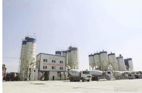
Trạm trộn bê tông Phúc Kiến.
