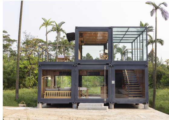
Xây dựng bằng phương pháp module.
