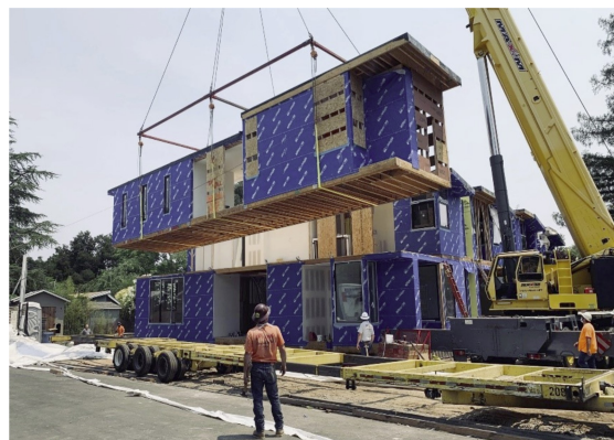
Plant Prefab chỉ mất ba ngày để lắp đặt những ngôi nhà được Metro Architects thiết kế riêng.
